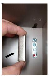
Wichtiger Hinweis: Sicherungsschraube 3 sollte beim einhängen ganz rausgedreht und Schraube 2 ganz reingedreht sein. Nach kompl. Ausrichtung die Sicherungsschraube 3 wieder ganz reindrehen. Alle Einstellungen mit einem Schraubenzieher bedienen nicht mit einem Akkuschrauber. Abdeckkappe aufsetzen, fertig.
