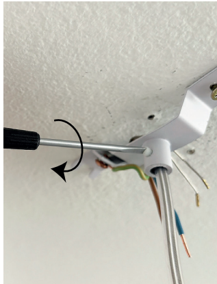
5 | Kabel auf Isolation sicher befestigen
