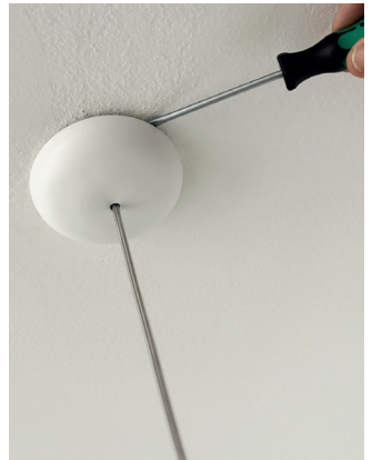
9 | Baldachin für Demontage mit Schraubendreher abhebeln
