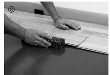
Bei Bedarf mit Schlagklotz leicht nachklopfen.
