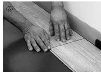
Die weiteren Elemente der ersten Reihe sind an den Kopfenden von oben in die vorherige Diele einzuklicken. Durch kurzen Druck auf den Querstoß rastet das Element im angrenzenden Element ein. Hierbei ist auf eine exakte Flucht der Elemente zu achten. Das letzte Element der ersten Reihe wird unter Berücksichtigung des Dehnungsabstandes von 10 -- 15 mm zur Wand zugeschnitten und eingefügt.
