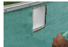
Fixing of the skimmer joint Fijación de la primera junta del skimmer Fixation du 1er joint de skimmer Befestigung der ersten Dichtung des Skimmers Fissaggio del primo giunto dello skimmer Bevestiging van de eerste pakking van de skimmer Fixação da primeira junta do skimmer
