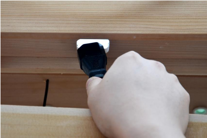
Bild 12: Stromkabel werden durch die Decke geführt
