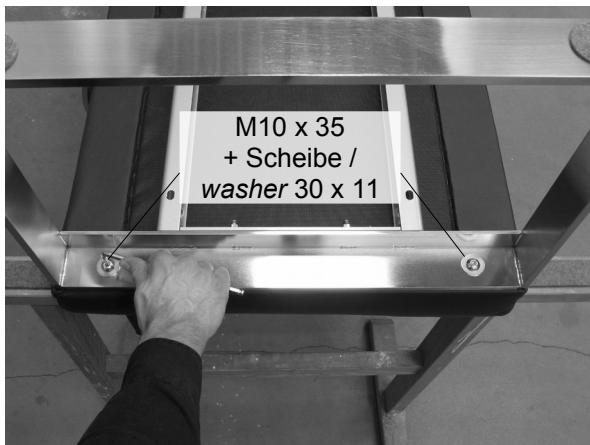
3. Die Metallrahmen mittig positionieren und mit je 2 Scheiben (30 x 11) und 2 Schrauben (M10 x 35) lose fixieren.
