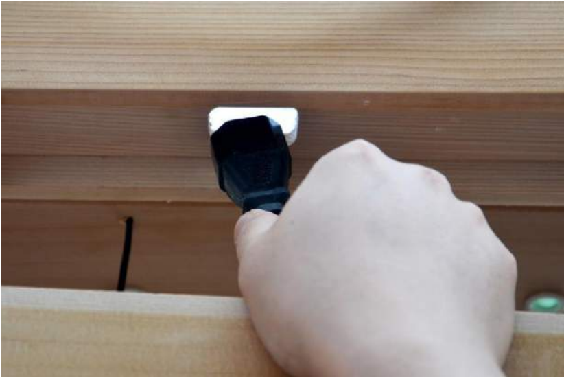
Bild 12: Stromkabel werden durch die Decke geführt
