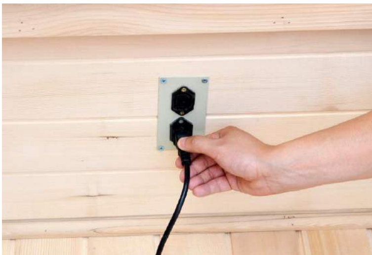
Bild 7: Anschluss Fußbodenheizung
