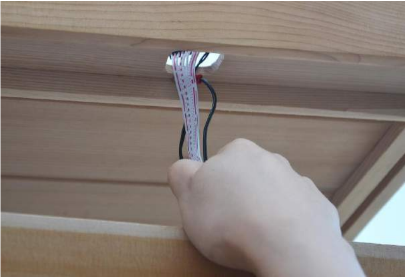
Bild 13: Kabel des Bedienelements/Temperatursensor/Radioantenne werden durch die Decke geführt
