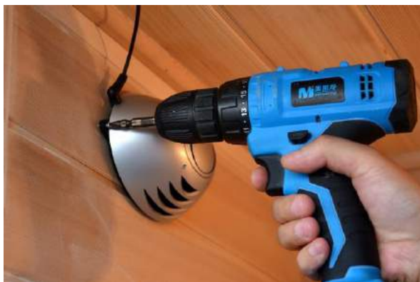
Bild 28: Befestigung Ionisator
