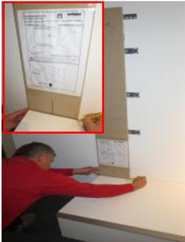
**Bild 3:** Bohrschablone außen bündig mit Unterteil anlegen und ausrichten
