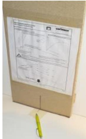
**Bild 4:** Anzeichnen der Mittelachse der Wandschienen mit der Bohrschablone
