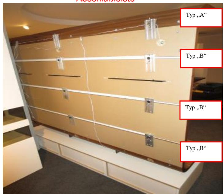
**Bild 17:** Rückwandansicht des montierten Paneel mit Beschlägen, Beleuchtungskabel-Führung, Schlitze für den Glasboden
