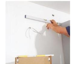
Montieren Sie zunächst die Unterschränke und richten Sie diese mit einer Wasserwaage aus.
