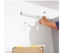
Una volta allineati con precisione, collegare i singoli mobili con delle viti. Si raccomanda caldamente l'utilizzo di due morsetti per evitare spostamenti o slittamenti. Prima di stringere i morsetti, applicare dei pannelli in legno sulle superfici dei mobili per proteggerle.
