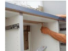
Ermitteln Sie durch exaktes Messen die Positionen der Bohrungen für die Hängebeschläge
