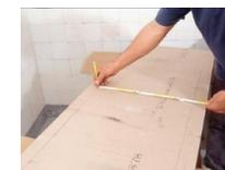
Přesným měřením určete pozici vrtaných otvorů pro závěsné kování.
