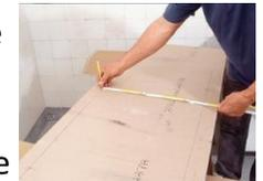
Auf der Unterseite der Arbeitsplatte reißen Sie im markierten Bereich den Herdplattenausschnitt auf. Mitteln Sie sie aus, so dass die Spüle mittig im Unterschrank sitzt und vorne und hinten die Plattenrestbreite gleich wird.
