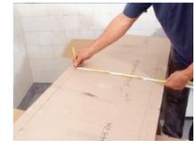
Ricavare un'apertura per il piano cottura sul lato inferiore del piano di lavoro all'interno dell'area tracciata, centrandola in modo tale che il lavandino rimanga al centro del mobile base e che la larghezza restante del piano anteriormente e posteriormente sia uguale.
