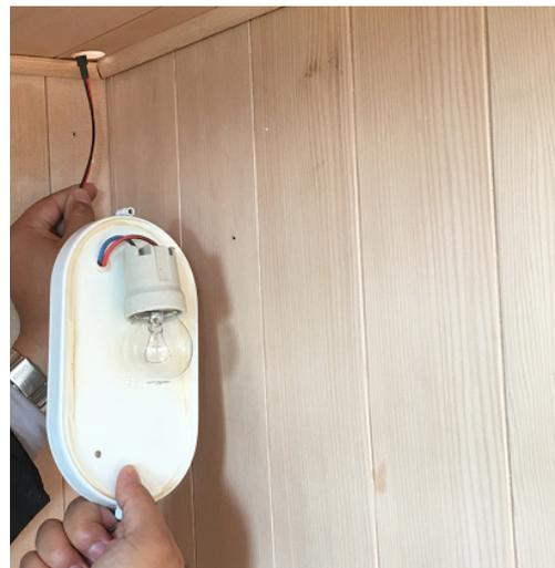
b. Führen Sie das Kabel durch die Öffnung der Oberplatte und verbinden Sie sie mit dem anderen Ende auf der Oberplatte. Befestigen Sie dann die Lampe.
