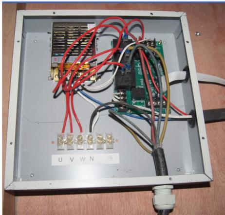
Die U V W N  $\perp$  Anschlüsse der Schaltbox auf der Oberplatte
