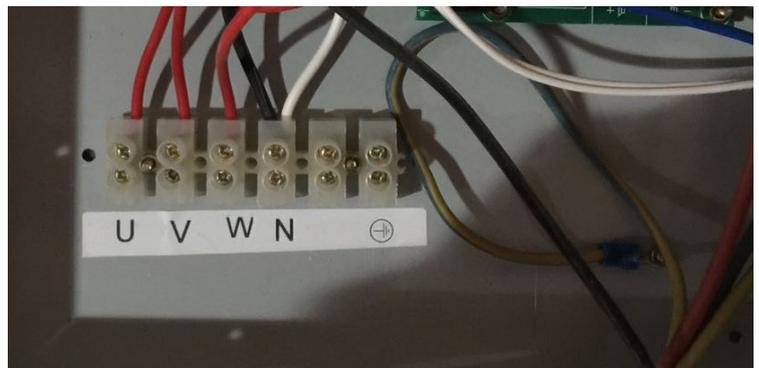
Die U V W N  $\perp$  Kabel des Saunaofens werden mit der Blockklemme der Schaltbox verbunden.
