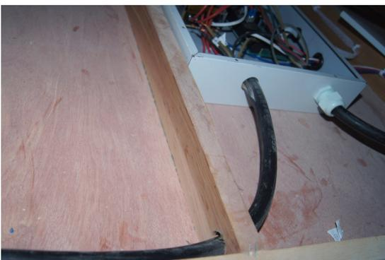
Kabel der Saunaöfen durch die Öffnung in der Oberplatte
