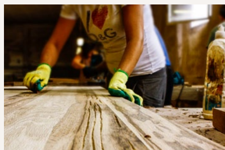
Schleifen eines zuvor ausgearbeiteten Risses
