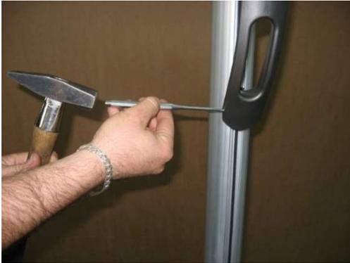
Mit einem Durchschlag den Zylinderstift  $\varnothing 5 \times 57\text{mm}$  entfernen. Neuen Clip einsetzen und Zylinderstift montieren.
