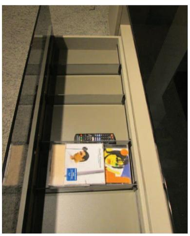
**Bild 31 , Einstellung Frontspalt mit Magnet**
