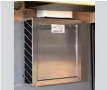
Der Profi-Plasmafilter befreit die abgesaugte Luft von Geruchsmolekülen, Viren, Bakterien und Schimmelsporen. Damit trägt er auch zur Luftreinhaltung im ganzen Wohnraum bei.
